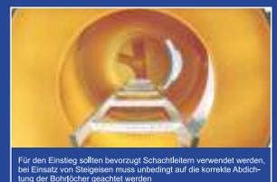
Für den Einsatz sollten bevorzugt Schachtletern verwendet werden, bei Einsatz von Stiegen muss unbedingt auf die korrekte Abdichtung der Bohrlöcher geachtet werden
