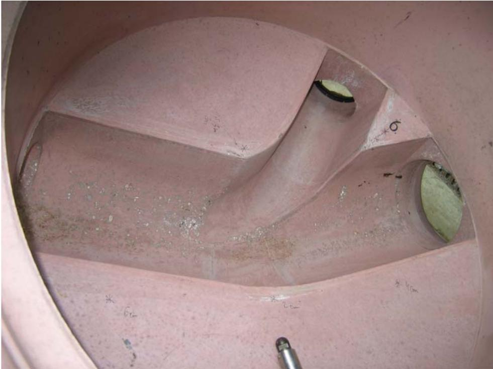
**Abbildung 23:** Schacht aus Hochleistungsbeton
