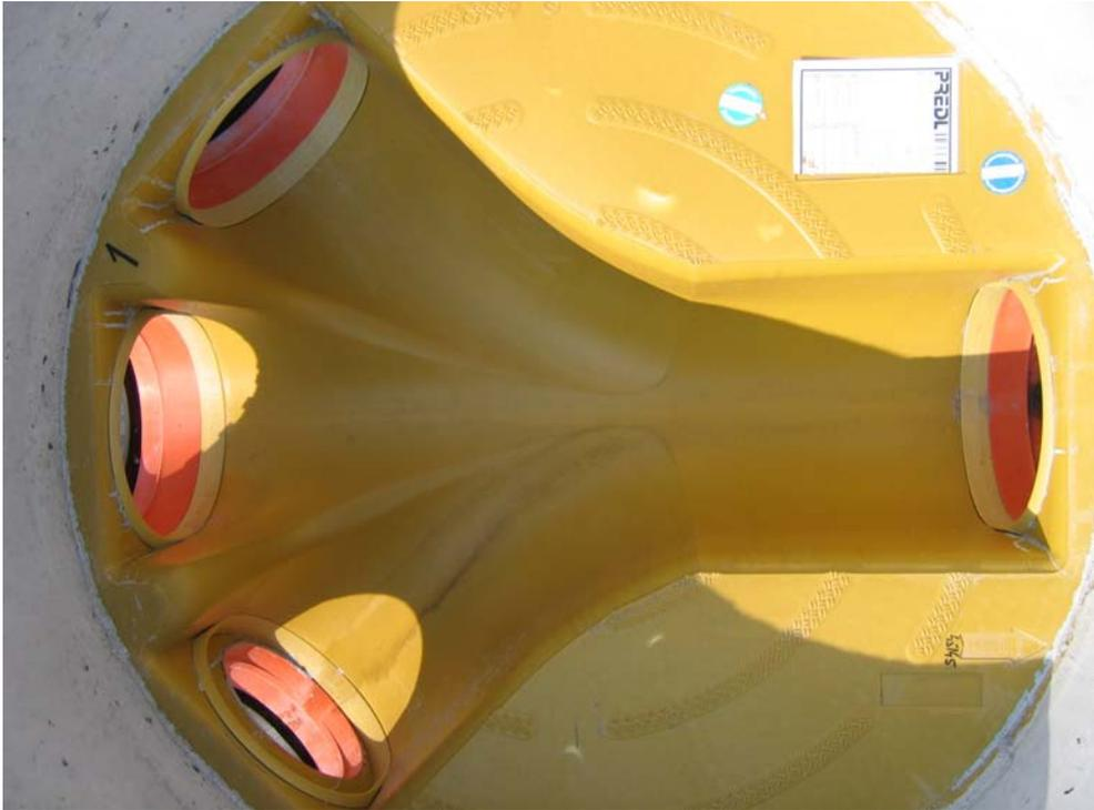
**Abbildung 2:** Fertigteilschacht mit tiefgezogener Schachtauskleidung aus PP
