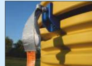
Augenschrauben in einrotierten Gewindehülsen zur Aufnahme von Einweg-Bandschlingen als Verlegehilfen
