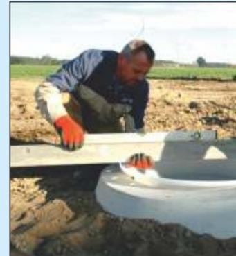
Das höhenverstellbare Teleskop kann bis zu 5 % dem Straßengefälle angepasst werden
